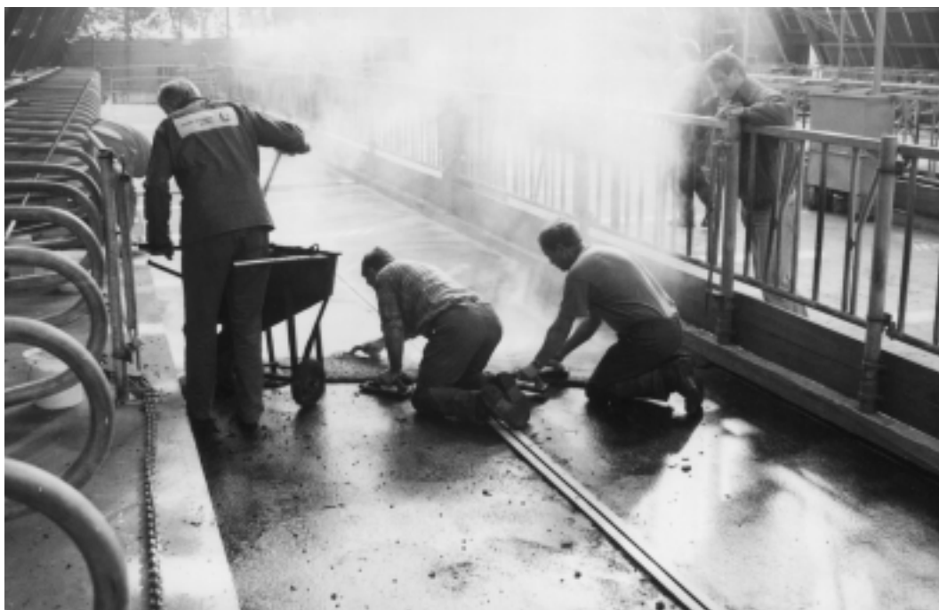
De warme asfaltmortel werd handmatig met een houten spaan verwerkt.
