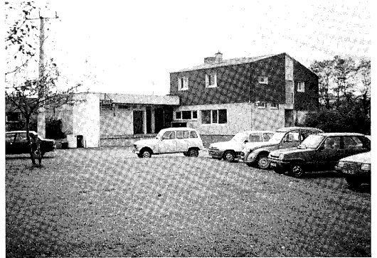
Vleeslaboratorium in Villers-bocage.
