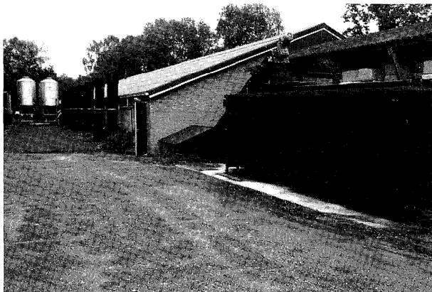
Via een gesloten mestafvoersysteem (goot met vizel) komt de mest uit de leghennenstal in een dichte container terecht.
