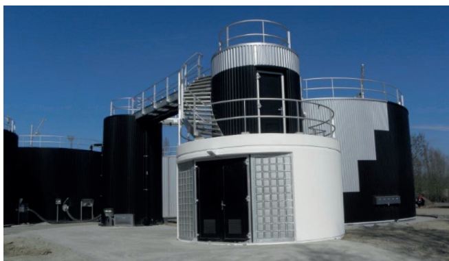
DEMON® INSTALLATIE RWZI NIEUWEGEIN
