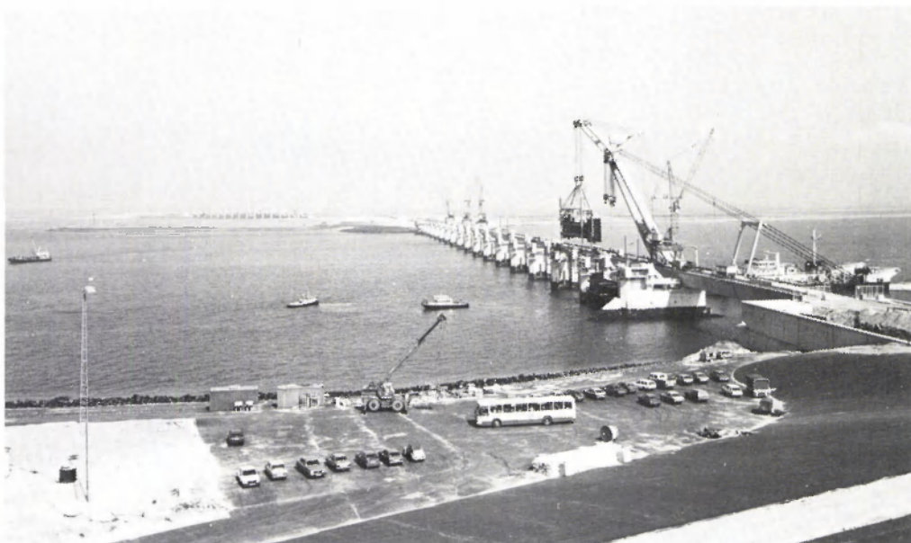
50 Plaatsing van een schuif in de Oosterschelddedam
