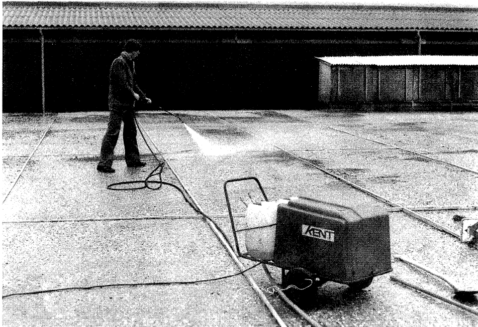
Het reinigen van de oude verharding met behulp van een hogedrukspuit. Cleaning of the old pavement with a high pressure cleaner.
