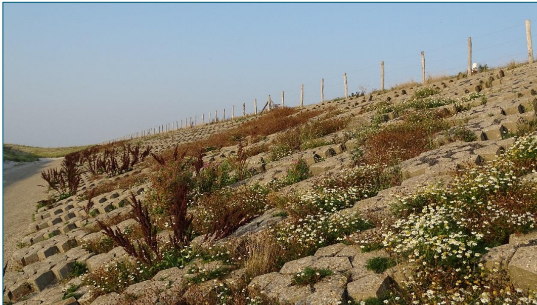
Afbeelding 4.5 Buitentalud van de oude Hondsbossche en Pettemer zeedijk (foto: Daisy de Vries)
