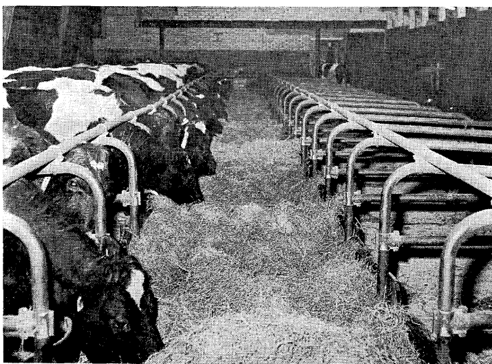
Tweerijige voerligboxenstal met centrale voerband (stal E).
