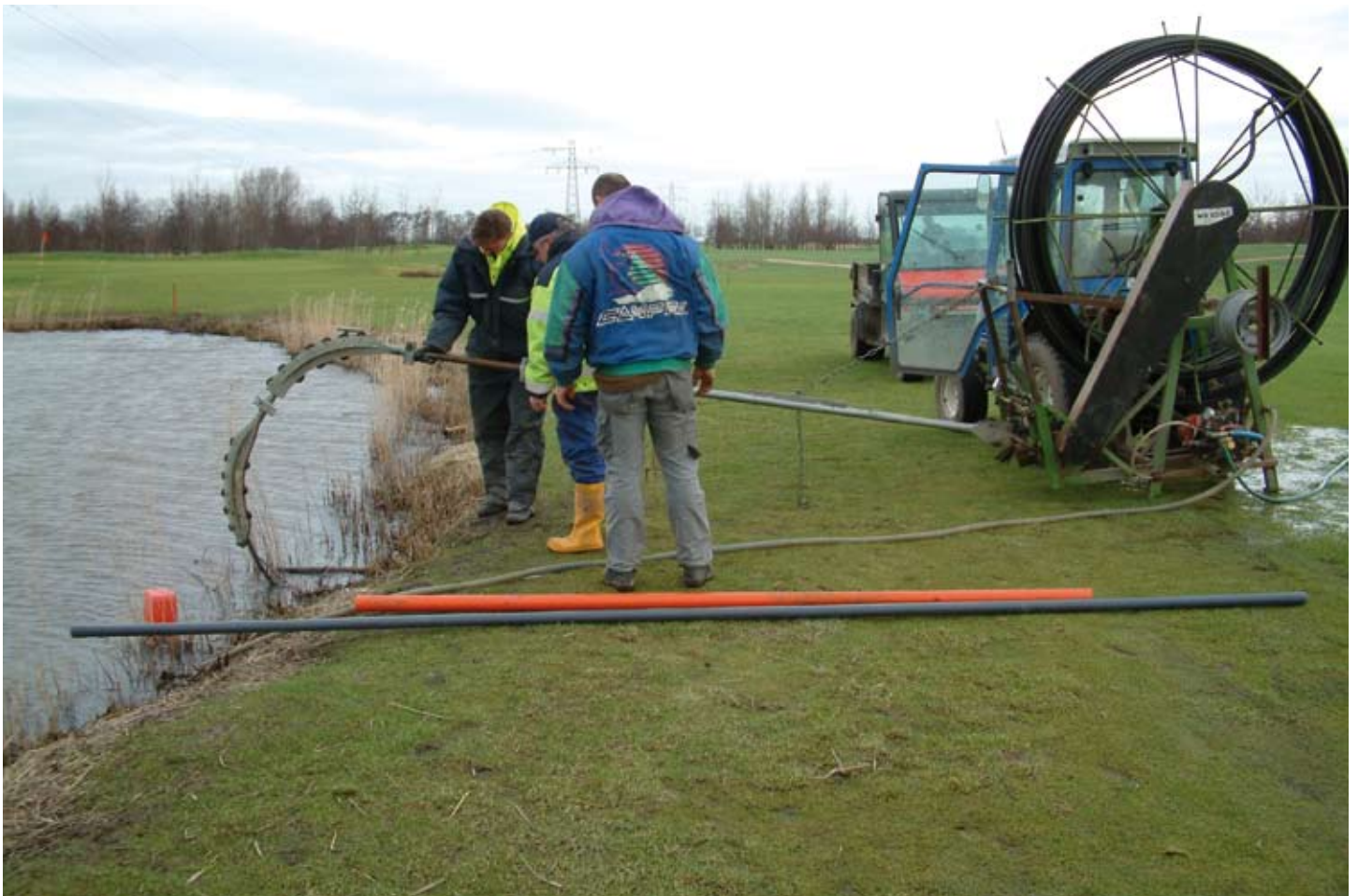
Doorspuiten drainagesysteem
