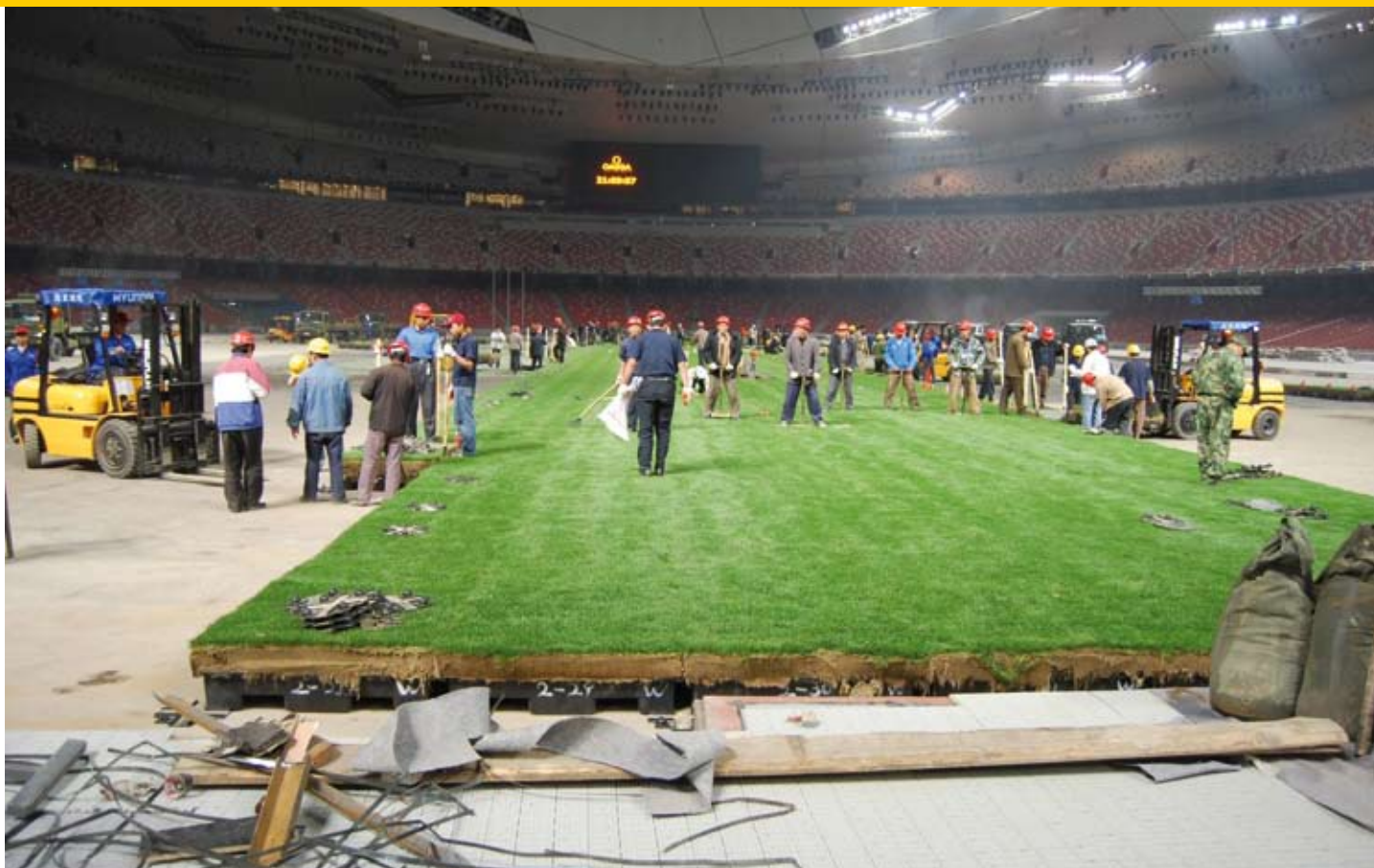
13 mei 2008, als deel van een test wordt het volledige modulaire veld naar het Bird's Nest stadion verplaatst.
