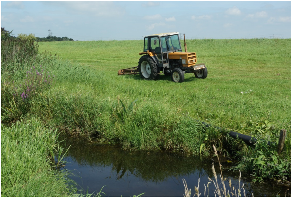
FIGUUR 3.2 TRACTORBEMALING IN DE UITERWAARDEN LANGS HET ZWARTE WATER TEN ZUIDEN VAN HASSELT. IN NATTE PERIODEN WORDT GEBRUIK GEMAAKT VAN EEN TRACTOR OM WATER UIT TE SLAAN OP HET ZWARTE WATER. IN DE SLOOTRAND DE LEIDING WAARMEE WATER UIT DE SLOOT WORDT GEPOMPT.
