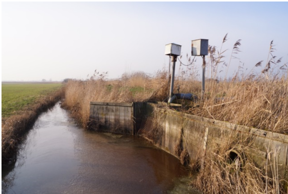
FIGUUR 3.3 GEBRUIK VAN POMP OM WATER UIT TE SLAAN OP HET ZWARTE WATER.
