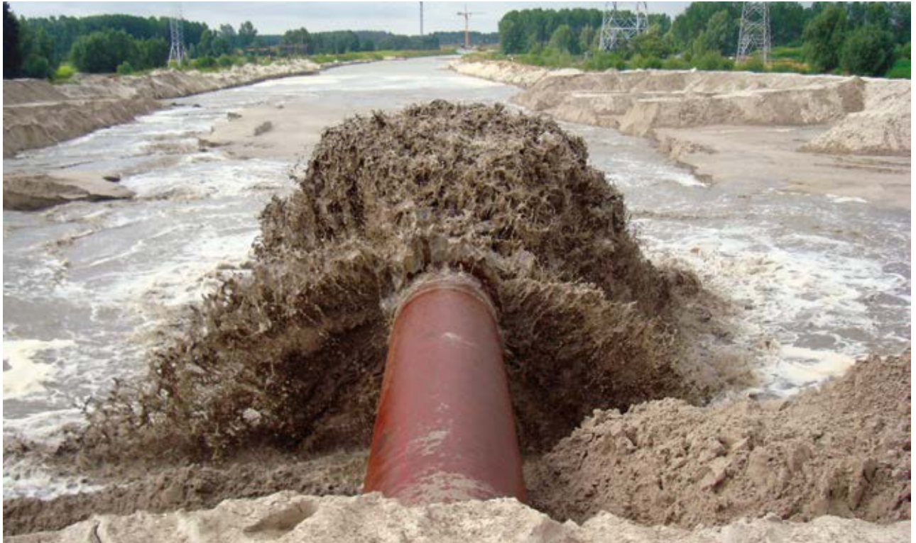
Figuur 8-14 Opspuiten van zandkern tussen twee perskades (bron: Daan Jumelet, DEME).
