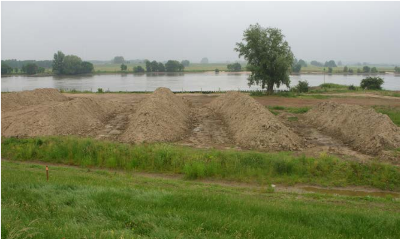
Figuur 8-13 Rijpingsveld naast dijk met kleiruggen (bron: Fugro).
