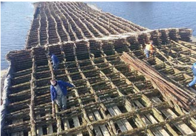
Figuur 2-6 Zink- en kraagstukken. Opbouw zinkstuk bovenaanzicht (A) en dwarsdoorsnede (B) (bronnen: [Boer en Kielman, 1956]). Foto's kraagstuk (C) en zinkstukken (D en E) (bron: fotocollectie aannemingsbedrijf van Aalsburg, Hellow).
