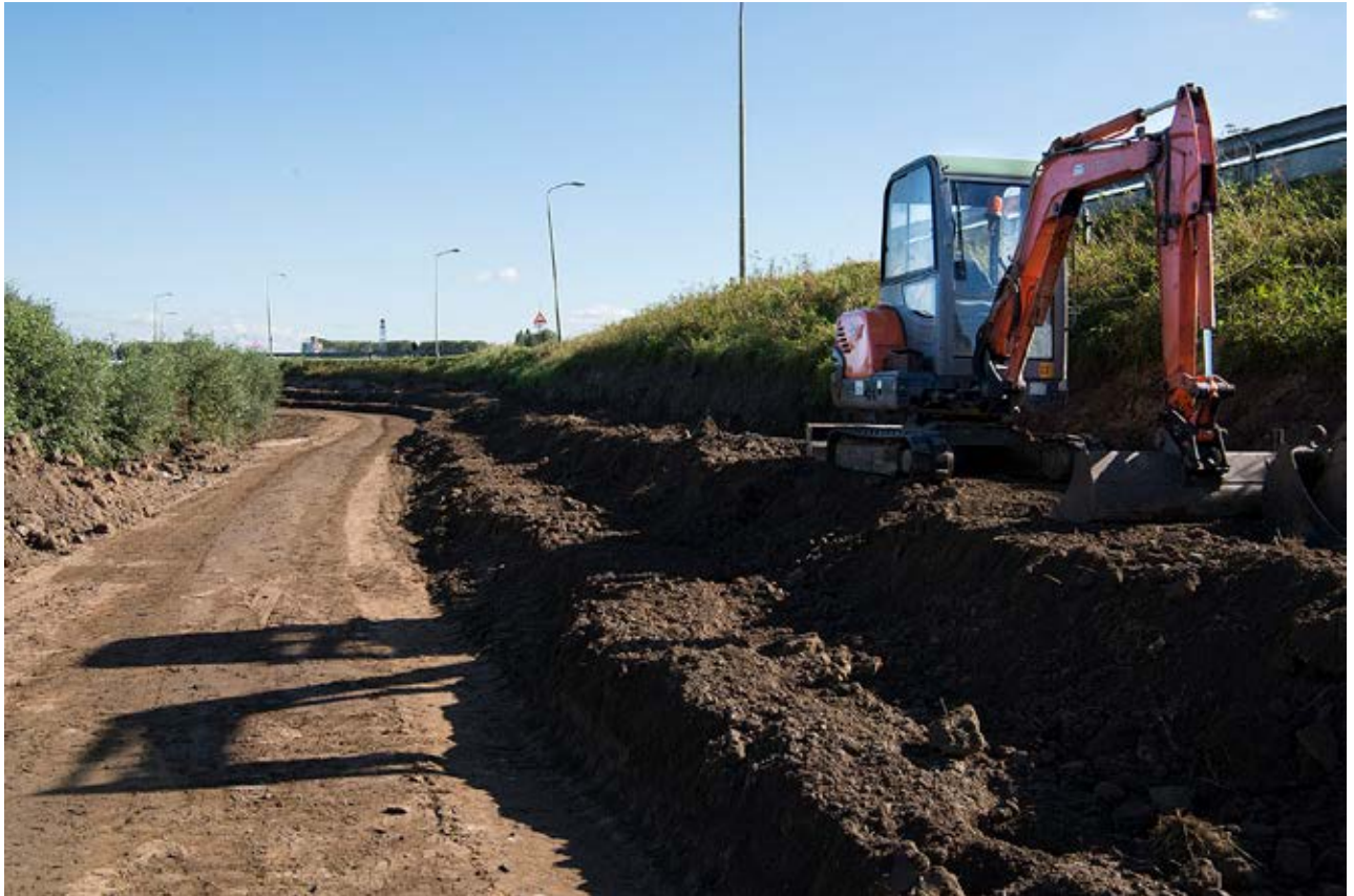
Figuur 8-2 Aanbrengen trapprofiel in binnentalud van dijk (bron: Herman Zonderland fotografie in opdracht van HHSK).
