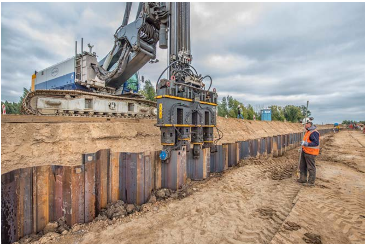
Figuur 9-2 Trillingsarme installatie van damwanden door middel van drukken met vierklems-methode (bron: Pascal Ogink, Combinatie dijkverbetering HOP (GMB - Van Oord)).
