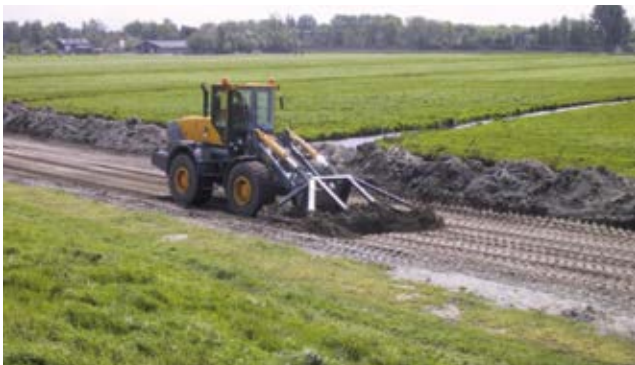
E - Laadschop met schuif om baan mee te egaliseren
