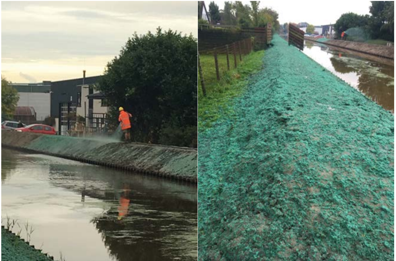
Figuur 8-7 Hydroseeding bij kade (bron: http://www.vanleeuwengww.nl/kadeverbetering-linschoten/ ).
