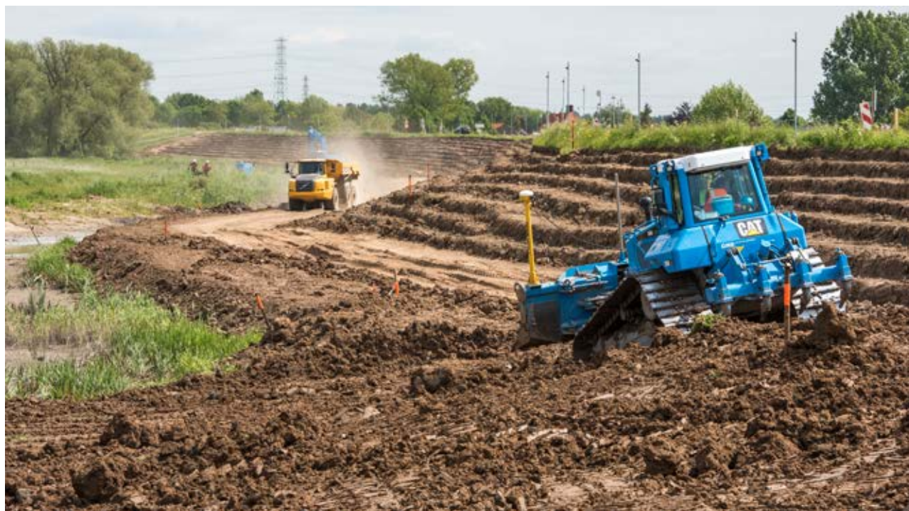
Figuur 8-11 Verdichting van grond bij dijkversterking Hagestein - Opheusden (bron: Pascal Ogink, Combinatie dijkverbetering HOP (GMB - Van Oord)).
