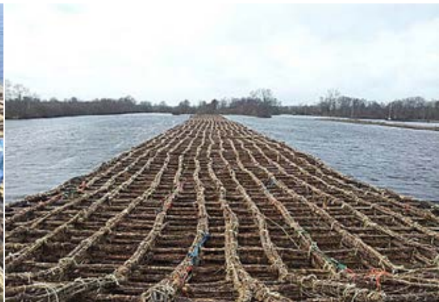
Figuur 2-6 Zink- en kraagstukken. Opbouw zinkstuk bovenaanzicht (A) en dwarsdoorsnede (B) (bronnen: [Boer en Kielman, 1956]). Foto's kraagstuk (C) en zinkstukken (D en E) (bron: fotocollectie aannemingsbedrijf van Aalsburg, Hellow).
