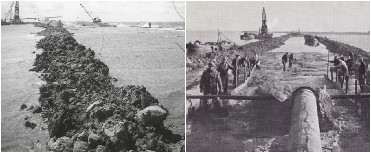
A B Figuur 2-15 Aanleg Houtribdijk aanbrengen zand tussen keileemkades (bron Rijkswaterstaat, fotocollectie Edzo Ebbens).
