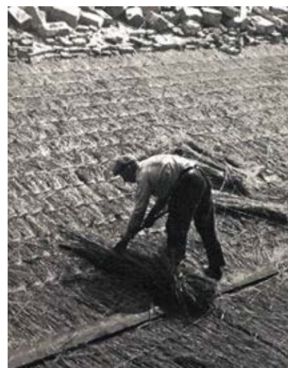
Figuur 2-8 Krammatten als grond dicht waterdoorlatend filter onder steenbekleding (bron: [Boer en Kielman, 1956]).
