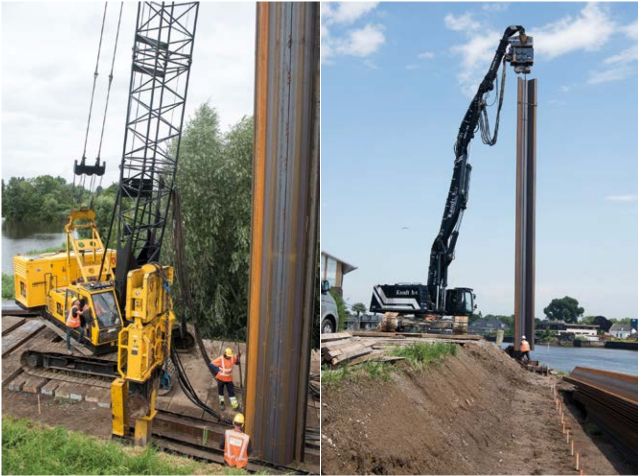
Figuur 9-1 Zwaar materieel bij aanvoer en installatie van damwanden in de teen van een dijk (bron: Herman Zonderland fotografie in opdracht van HHSK).
