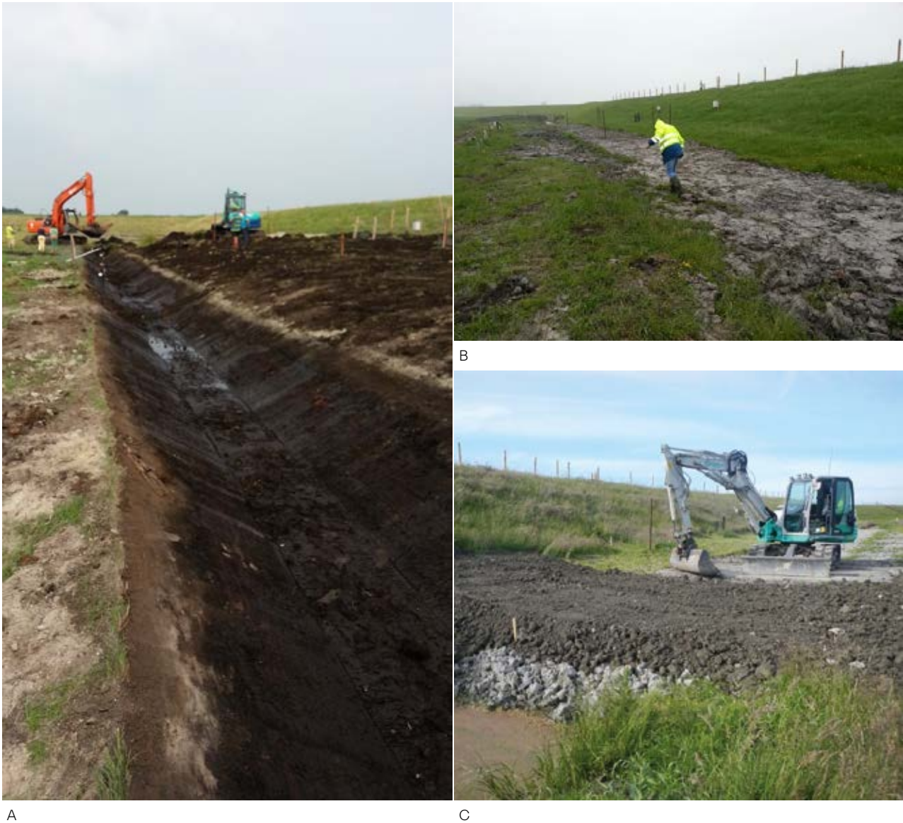
Figuur 8-3 A: graven van een nieuwe teensloot, B: gedempte sloot, C: eerste ophoogslag (bron: Hoogheemraadschap Hollands Noorderkwartier).
