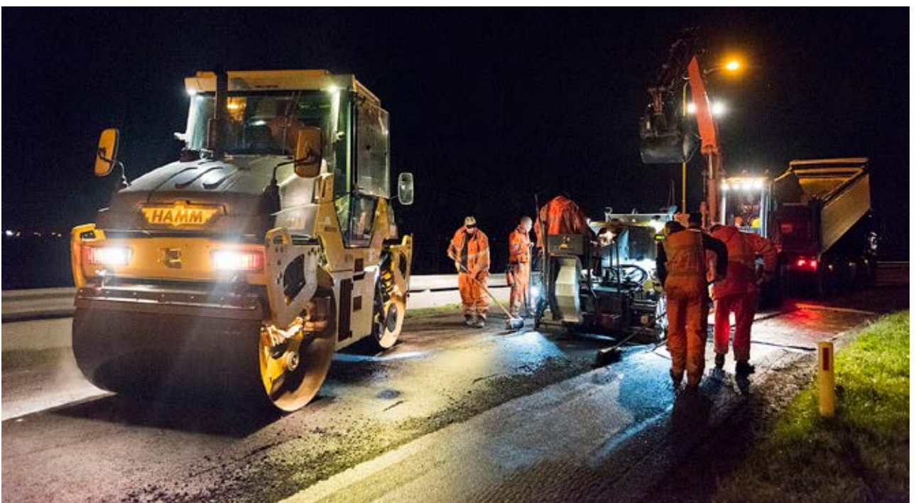
Figuur 8-10 Nachtelijk asfalteren van dijkweg (bron: Herman Zonderland fotografie in opdracht van HHSK).
