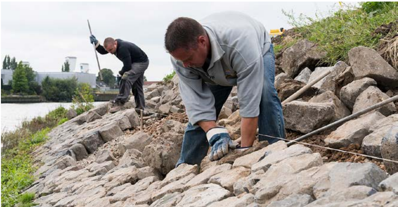
Figuur 8-19 Kleinschalig handmatig aanbrengen van een basaltglooiing bij de versterking van de IJsseldijk bij Capelle in 2017 (bron: bron: Herman Zonderland fotografie in opdracht van HHSK).
