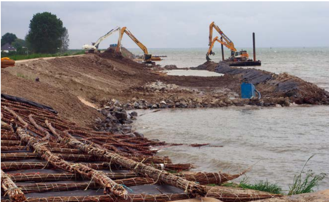
Figuur 8-15 Vingerling bij de versterking van de Zuiderdijk van Drechterland (bron: Werner Halter, Fugro).
