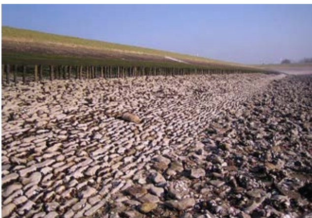
E. Vilvoordse steen uit België. Vooral toegepast in Zeeland (bron: Provinciale Zeeuwse Courant, 2009).
