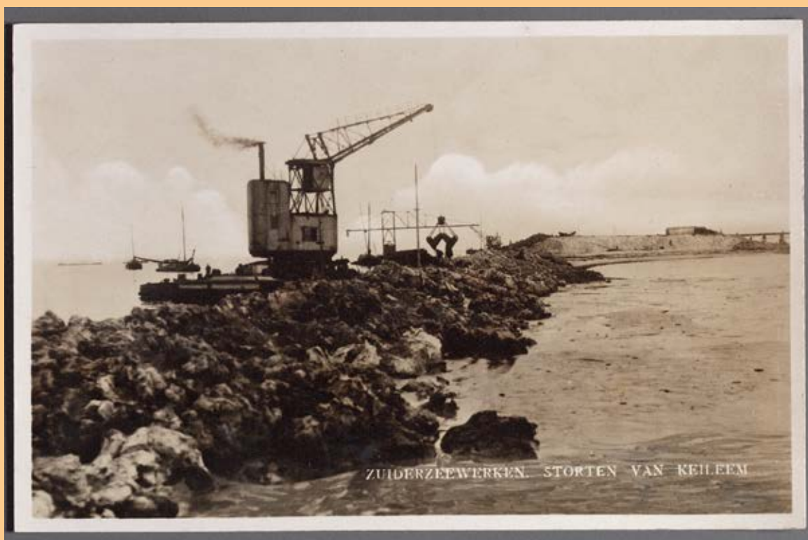
Figuur 2-17 Een drijvende kraan stort keileem op een dijkvak (bron: [Zuiderzee collectie, 1928 - 1929]).
