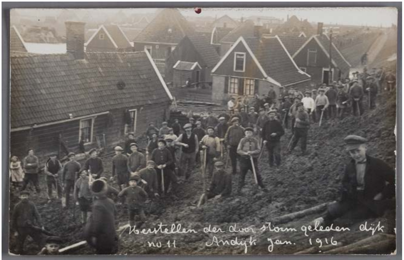
Figuur 2-12 Herstel dijk bij Andijk, 1916, met handwerk komt allerlei materiaal in de dijk (bron: Jonker, Zuiderzeecollectie, 1916).
