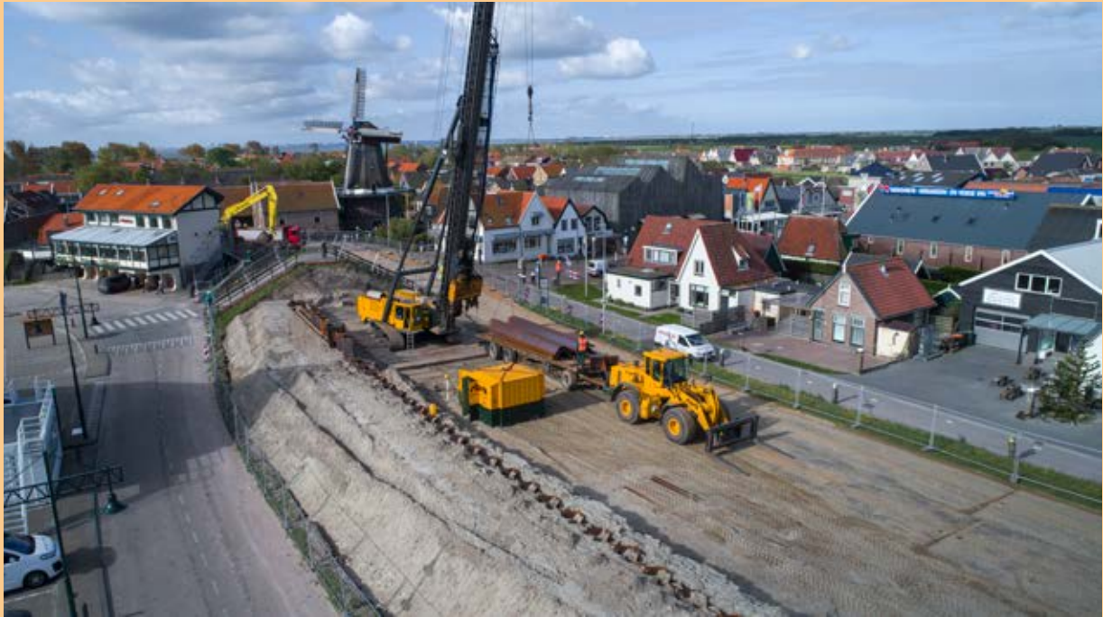
Figuur 7-1 Quattropiler op de kruin van de dijk naast bebouwing in Oudeschild, Texel (bron: Hoogheemraadschap Hollands Noorderkwartier).
