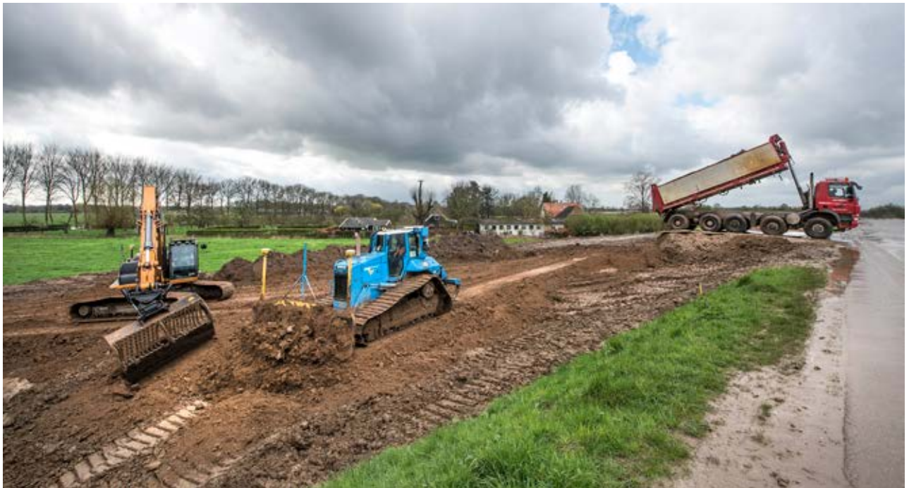
Figuur 3-3 Aanvoer van klei met een vrachtwagen met kipper (rechts), verdichting en uitspreiding van klei met een bulldozer (midden) en uitspreiding van klei met een kraan met kettingbak (links) (bron: Pascal Ogink, Combinatie dijkverbetering HOP (GMB - Van Oord)).
