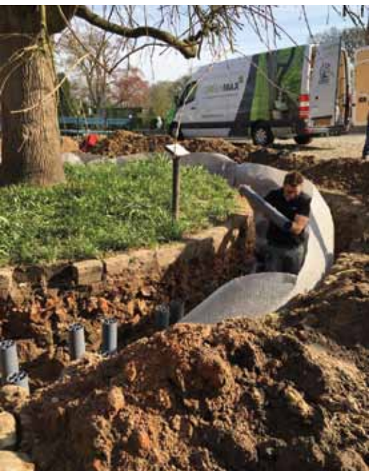
Aanleg van het boombunkersysteem.
