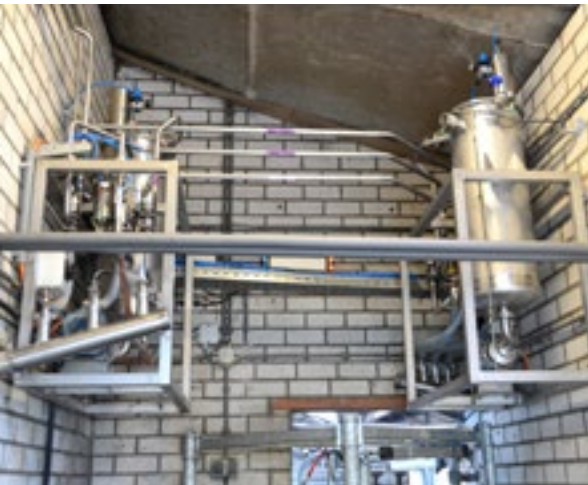
Vanuit het melkglas van de robots wordt de melk in deze buffers gepompt, waarna het door een dunne leiding naar een separatieunit gaat.
