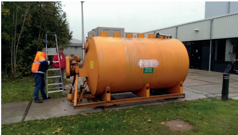
GEROERDE TANK 10 M 3
