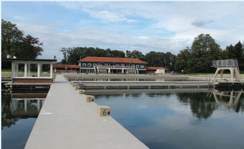
Het strandbad in Winterswijk, met badmeesterkiosk, paviljoen en duiktoeren. Foto Ciell, Wikimedia Commons.
