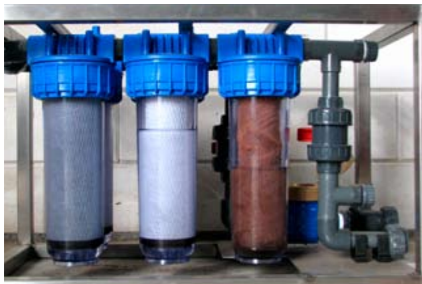
Filter voor condenswater. Eerst een filterkaars (bruin) voor opvang van verontreinigingen en vervolgens 4 actief koolfilterkaarsen achterelkaar in serie voor opvang van Actellic
