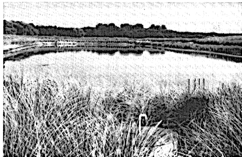
Infiltratieput met drains, die het voedingwater verzamelen voor de persput IP1 van het PWN. (Foto: PWN).
