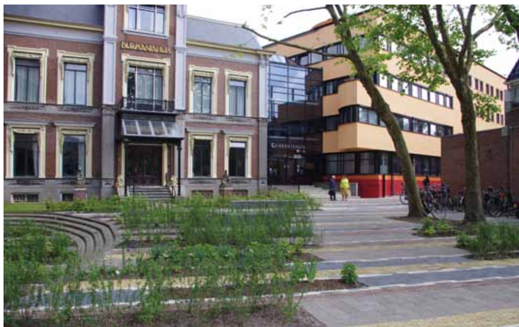
Operatie Steenbreek heeft de entree naar het gemeentehuis getransformeerd.
