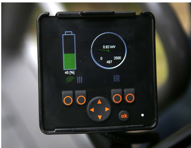
In de cabine geeft een kleine terminal de resterende stroom en de opgenomen energie aan.
