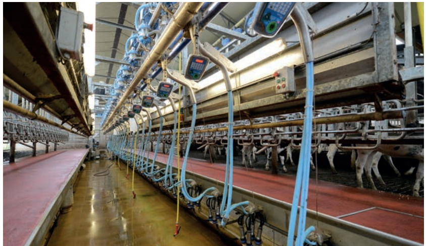
De recent gebouwde 2x24-swing-overmelkstal
