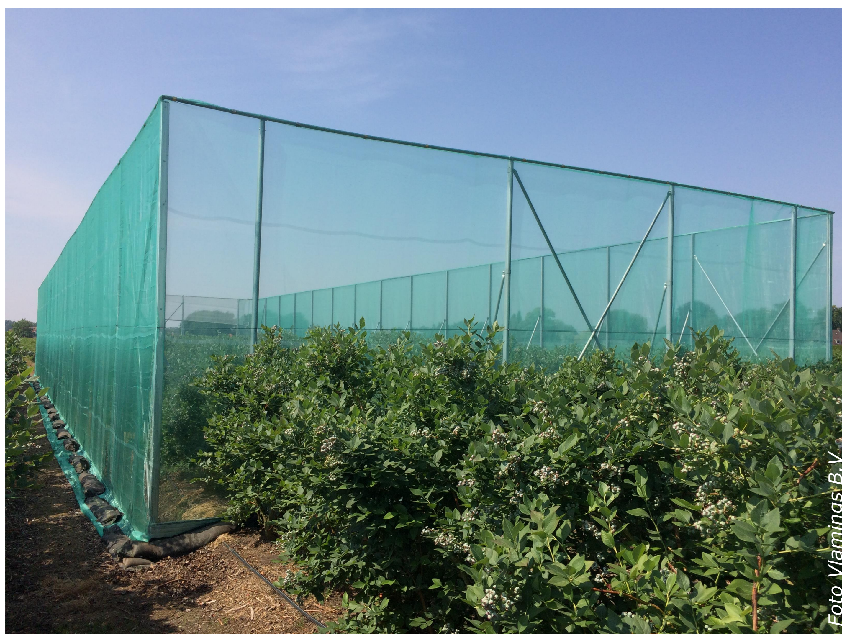
Figuur 1. In een perceel blauwe bessen 'Aurora' werd een stuk van 30 bij 10 meter omheind met Ornata Air Plus gas (0,77x1,02 mm) van 3.5 m hoog. De constructie heeft geen dak, dus de bovenkant is open. Toegang via een roldeur aan de kopse kant van het perceel.
