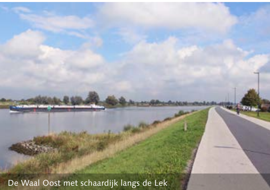
De dijk als ontginningslint aan de oostzijde
