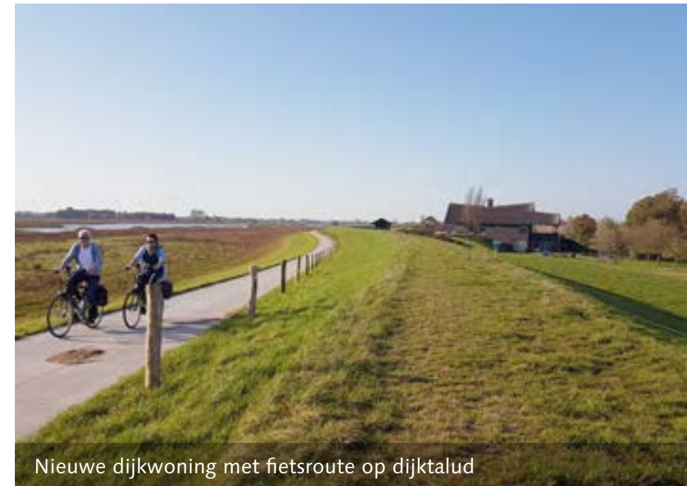
Fietsroute op en langs de nieuwe dijk
