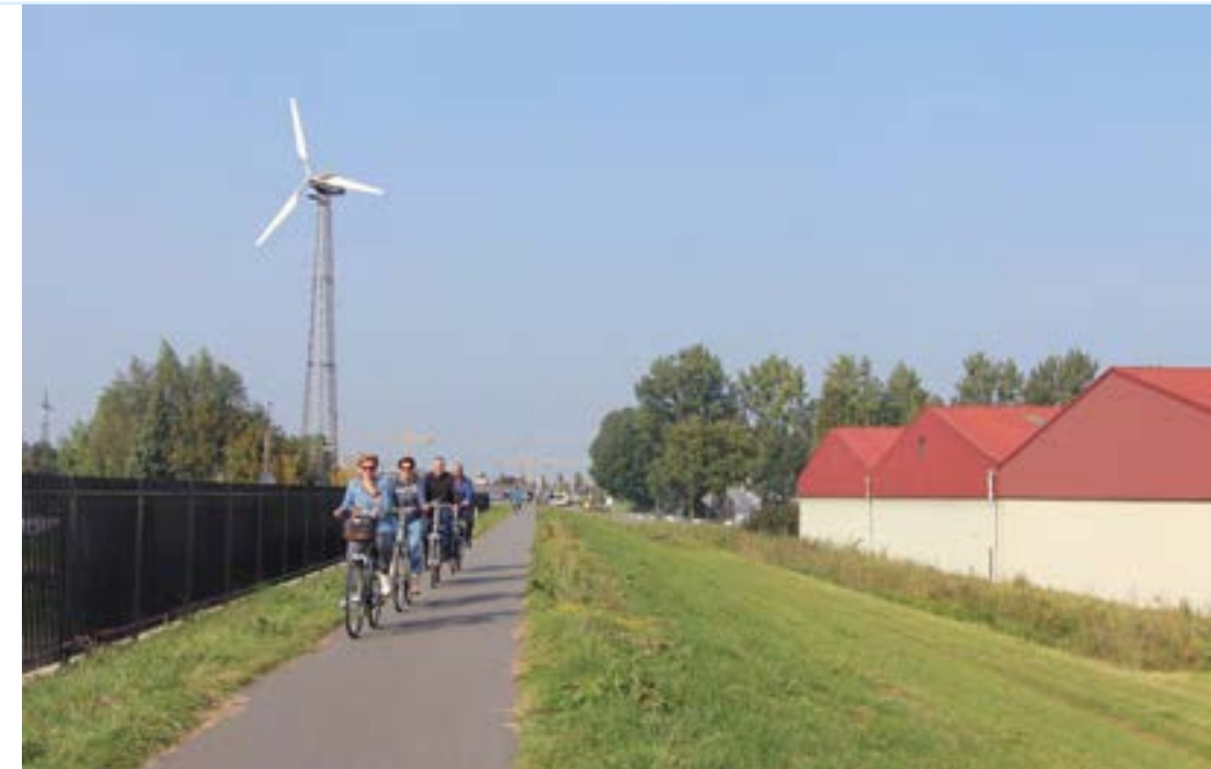
Nieuw hekwerk rond jachthaven Werkendam
