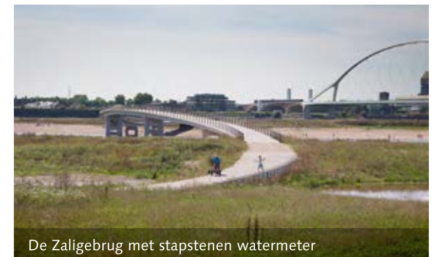
Verlengde Waalbrug met bastion
