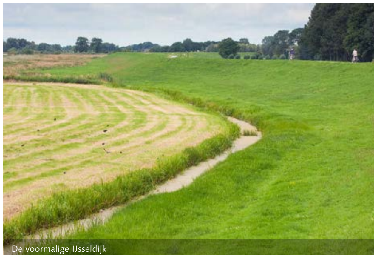
De PKB maatregel dijkverlegging Westenholtte
