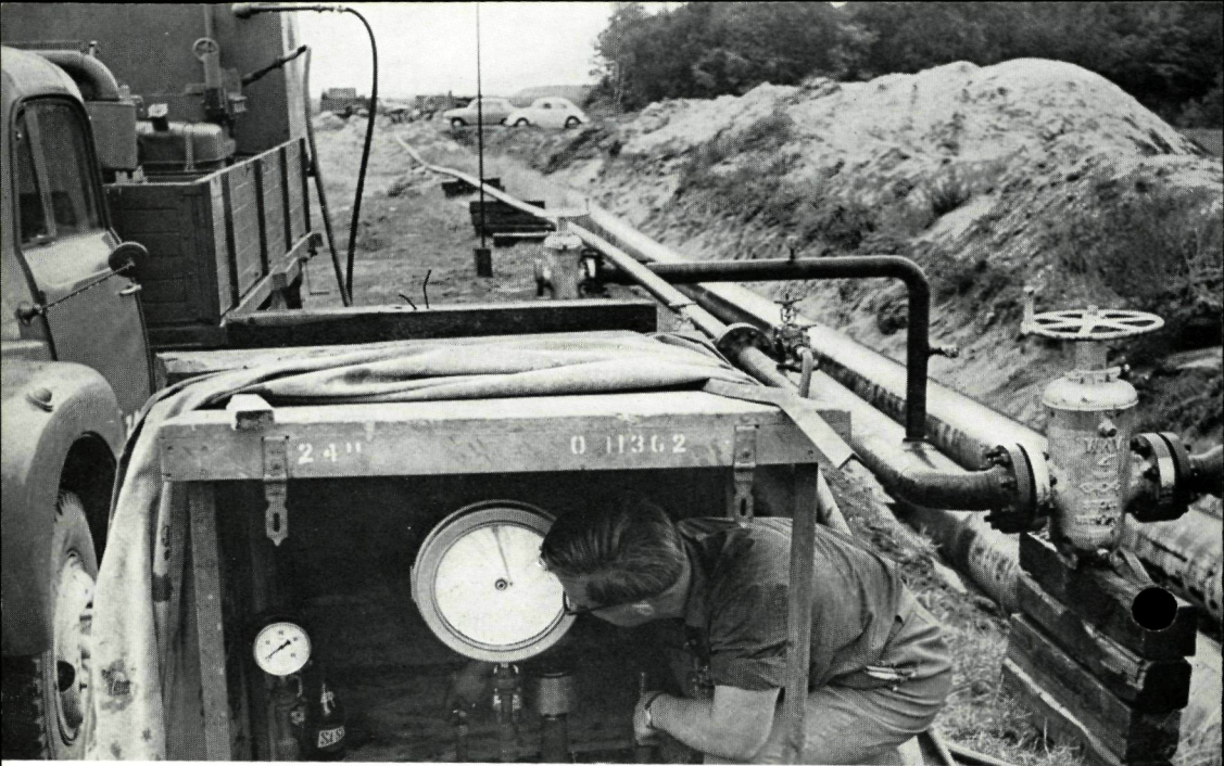
De gereedgekomen leiding wordt aan hydrostatische drukproeven onderworpen
