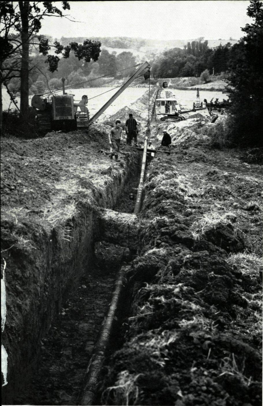
Het leggen van een pijpleiding ergens in Zuid-Engeland
