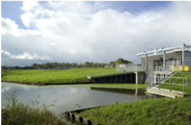
Het Rottegeemaal handhaaft het gewenste waterpeil in de polder
