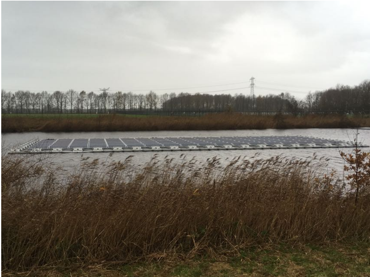
Fig. 3.7 Foto zonnepanelen op het water (foto: Wattco, Maasdijk).
