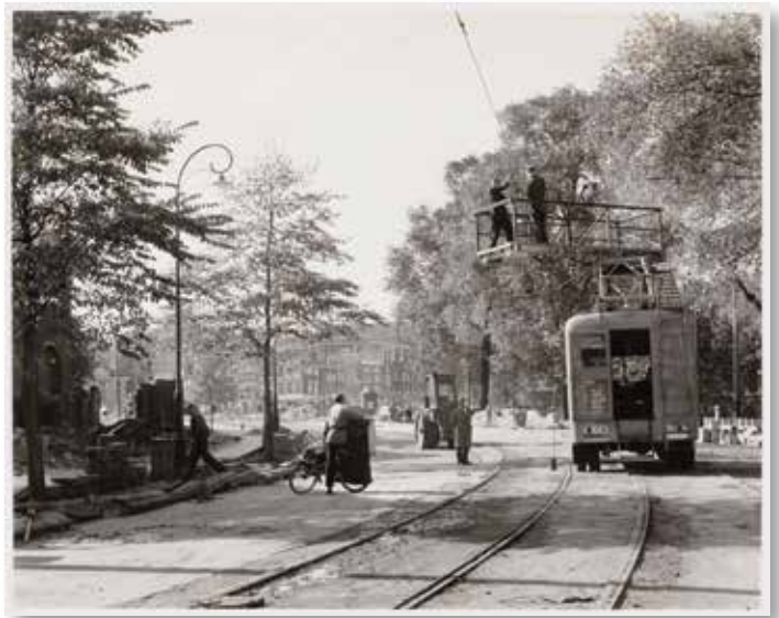
Het snoeien van takken rond bovenleidingen mag alleen worden uitgevoerd door medewerkers van de sectie Boomwerk. Daarbij wordt gebruikgemaakt van de montagewagen van het Gemeentelijk Vervoerbedrijf.
