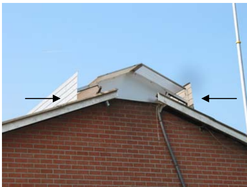
Pijlen wijzen naar opstaande randen ('venturinok'), aangebracht op melkveestal Bomers
