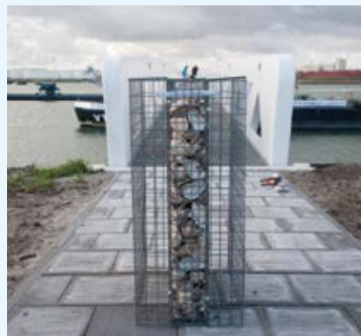
De oesterschelpen vormen een ideaal substraat voor voedselorganismen, terwijl de dubbele constructie bescherming biedt aan jonge vis.
