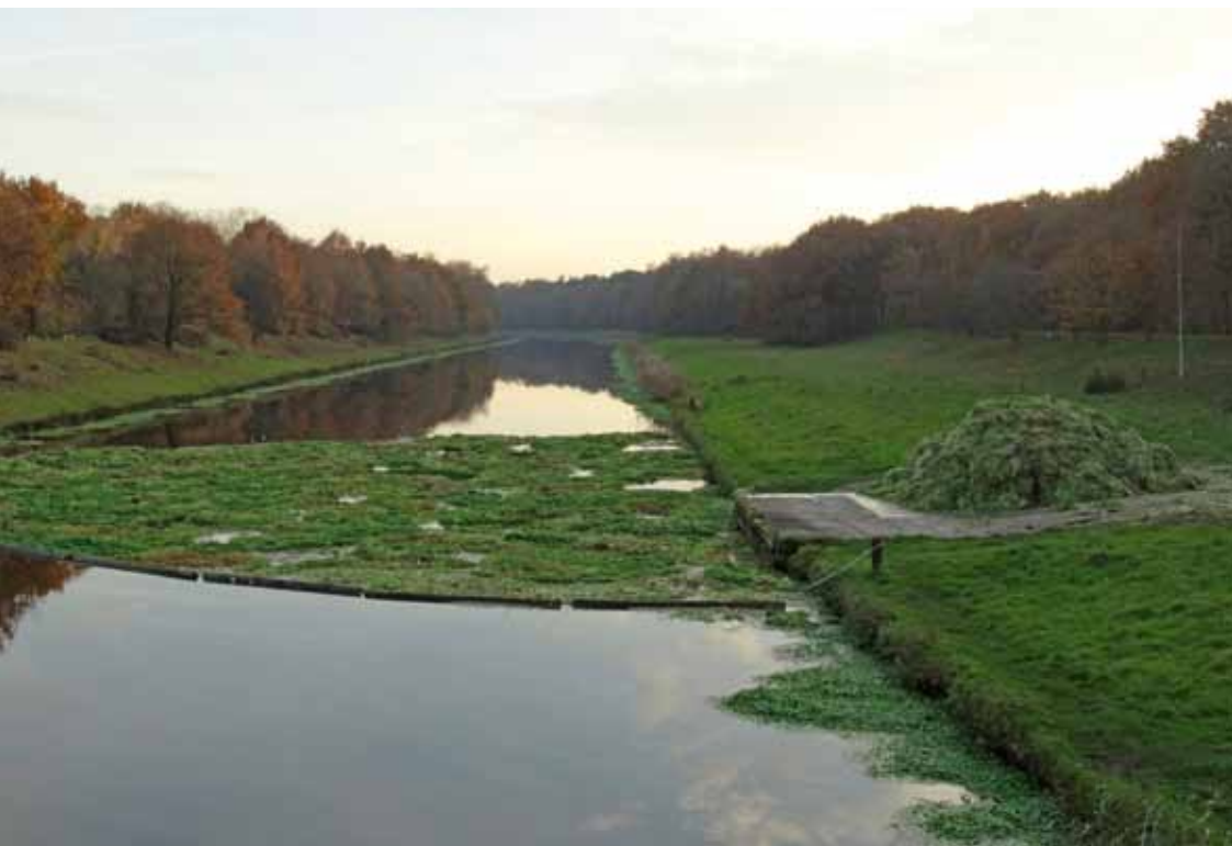
Het volgroeien van watergangen kan leiden tot verminderde waterdoorstroming omdat gemalen en stuwen geblokkeerd kunnen raken met verhoogde waterpeilen tot gevolg.
