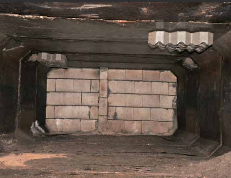
Achterzijde van de duiker is dichtgemetseld met kalkzandstenen blokken. De kleine deuropening zorgt voor stabiele temperatuur en luchtvochtigheid.
