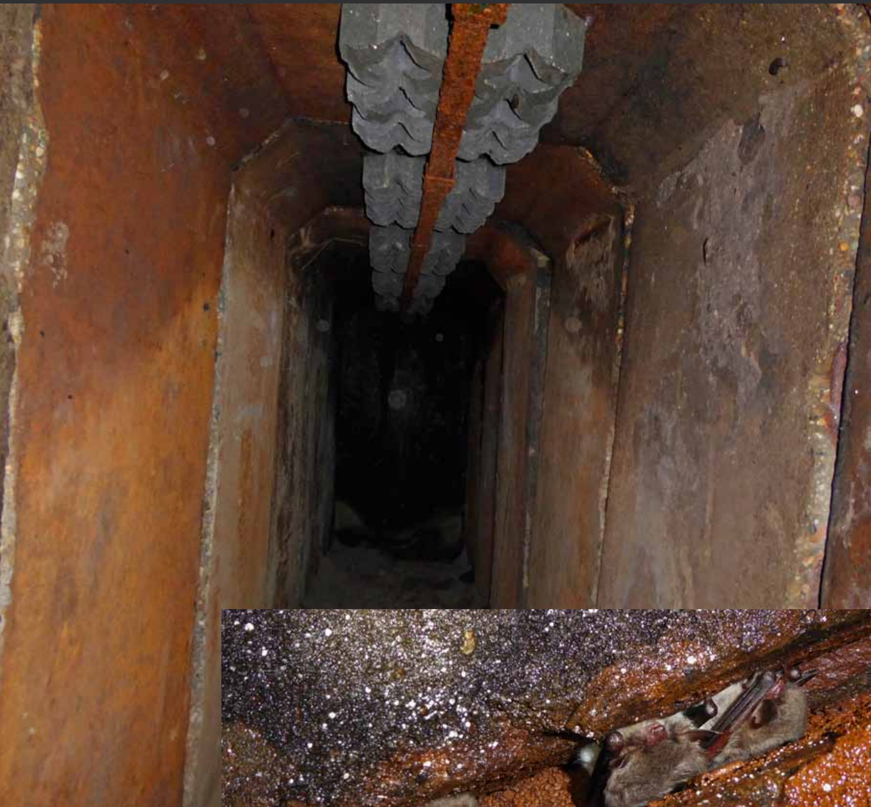
Grasbetontegels gemonteerd aan het plafond.
