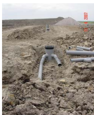
Foto 1: gescheiden stelsel voor perssap en erfwater
