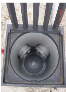
Foto 2: afvoer van perssap en erfwater
