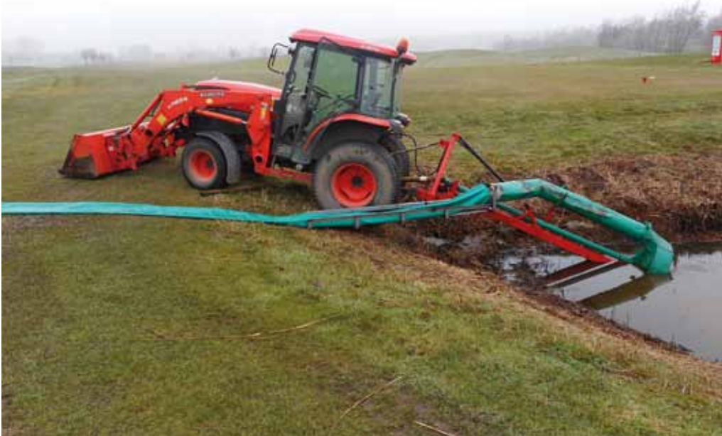
Tractorvijzelpomp bij doorspuiten drainage.
