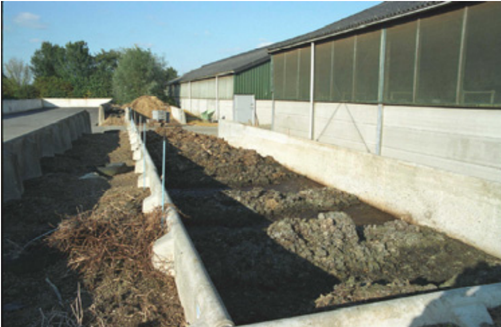
Sleufsilos met mesthoopjes van de tweede afmestronde
