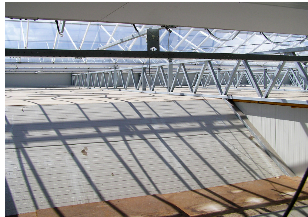
Foto 2 Variant van het type bedekte zonnecollector waarbij de schuurruimte door sandwichpanelen goed geïsoleerd is van de ruimte met glasdek
