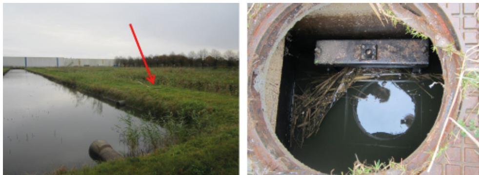
Figuur 2.7 Einde bezinksloot met duiker naar vloeiveld 1 (links) en afsluiter in de duiker (rechts)
