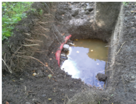
Figuur 2.12 Monsternamekast bij ontvangstput helofytenveld (locatie C, links) en opgegraven debietsensor in aanvoerende persleiding (rechts)
