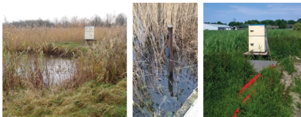
Figuur 2.13 Monsternamekast bij overgang bezinksloot naar vloeiveld 1 (locatie D, links), niveaumeting aan einde vloeiveld 3 (locatie E, midden) en monsternamekast bij effluentput (locatie E, rechts)
