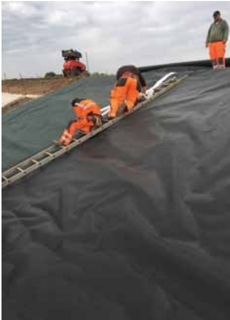
Het verlijmen van de naden van het doek.
