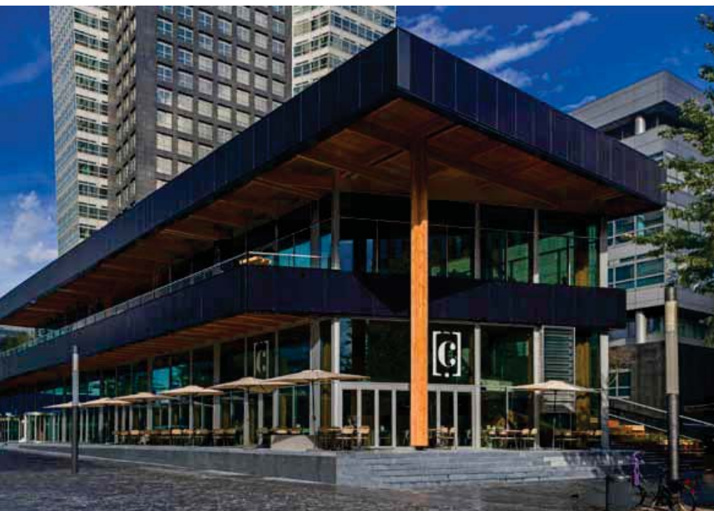
'Circl' is een energiezuinig, demontabel multifunctioneel (buurthuis, restaurant, dakterras) gebouw. In Circl is zo'n 700 m 3 inlands hout verwerkt waaronder larikshout in de gelamineerde constructies en wanden.
