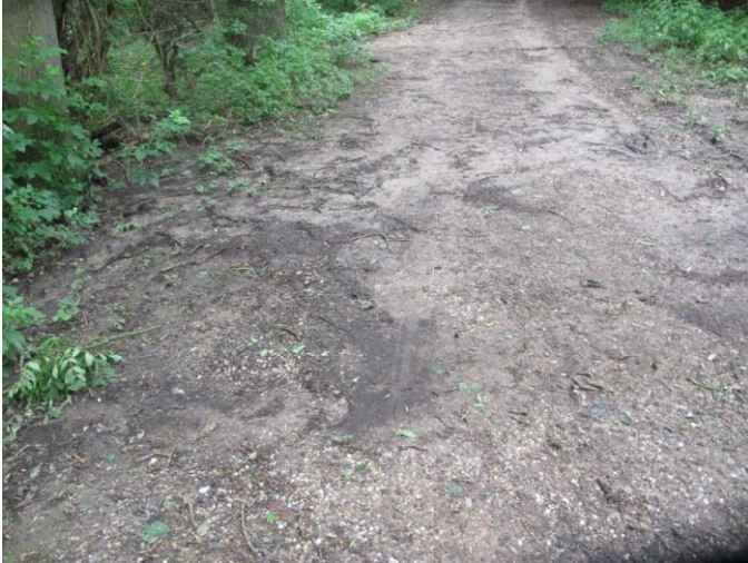
Figuur 2.3.6: Afstroom van water en sediment over een contourvolgende weg in het Savelsbos. Op het laagste punt van de weg stroomt het sediment alsnog het bos in (links) (foto: Rein de Waal, 2016).
