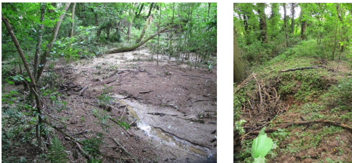
Figuur 6.9: Kloosterbos. Links: Opvang van sediment in een dalvormige laagte. Rechts: Ondermijning van een dam door te hoog aanbod van water en sediment (foto's: Rein de Waal, 2016).
