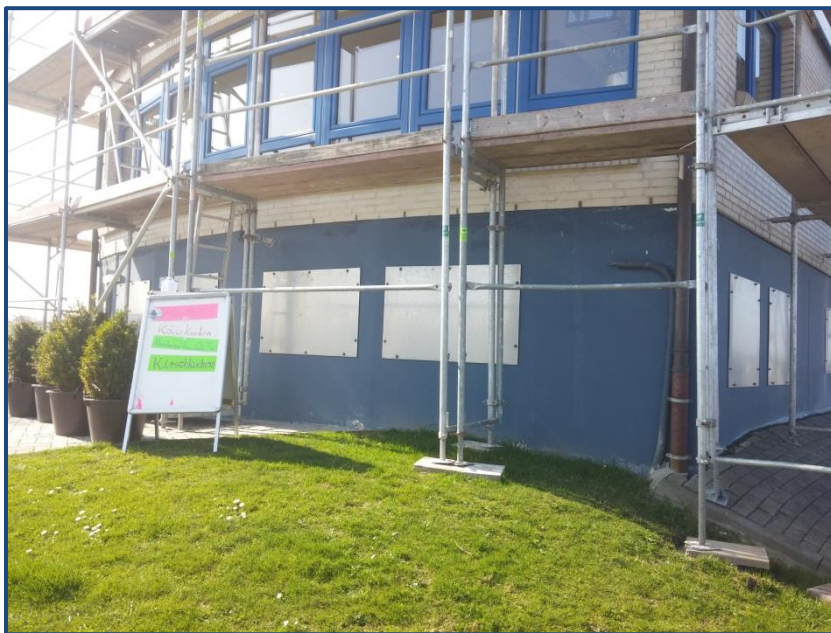
Figuur 49: Beton en metalen platen tegen de zee (eigen foto)
