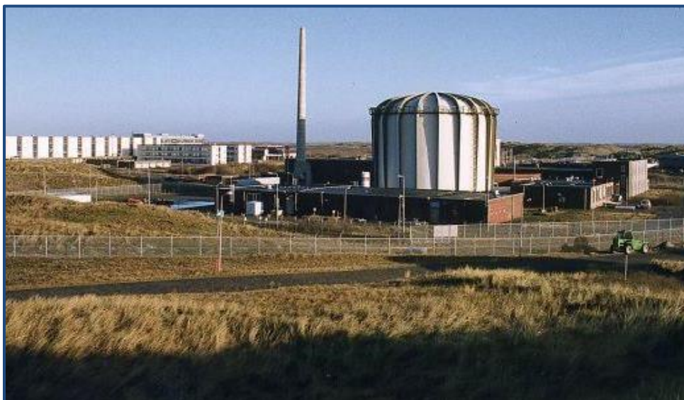
Figuur 7. Onderzoekslocatie Petten (ECN, 2001)
