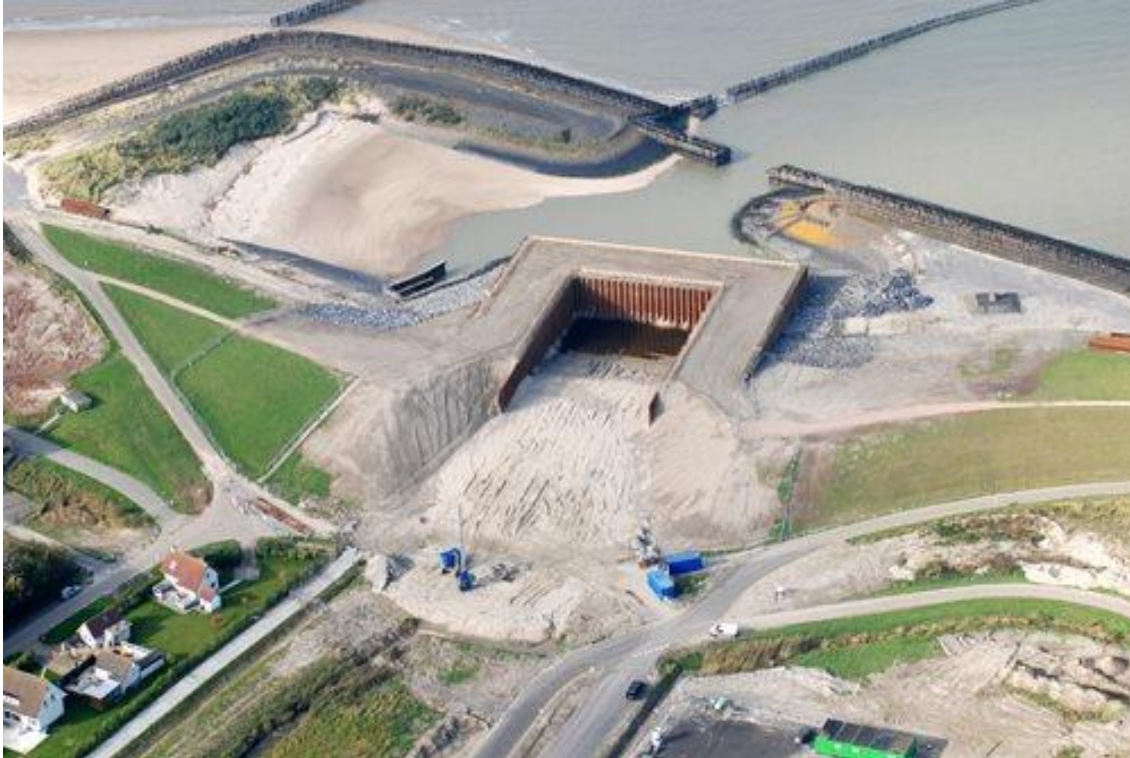
FIGUUR 16. AANLEG GETIJDENDUIKER WATERDUNEN. (IV GROEP, 2009)
