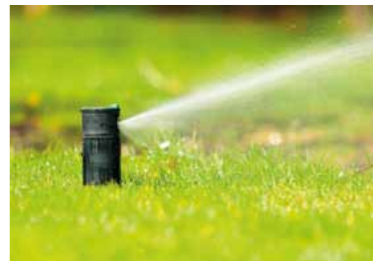
... springen op het festivalterrein de verschillende sproeiers aan. De voorspelling is droog weer, maar het beschadigde gras kan wel een slokje gebruiken. De doseringspomp die gekoppeld is aan de beregeningscomputer voor deze wijk, voorziet het regenwater van stoffen die het herstel van het gras moeten stimuleren.
