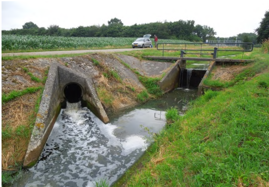
FIGUUR 4-1 RWZI-EFFLUENT LOZINGSPUNT OP DE BOLSCHERBEEK BIJ HAAKSBERGEN IN DE ZOMER VAN 2015. LET OP HET VERSCHIL TUSSEN DE ZEER BEPERKTE ‘NATUURLIJKE’ AFVOER OVER DE STUW EN DE OMVANG VAN DE EFFLUENTSTROOM (FOTO: BAS WORM).
