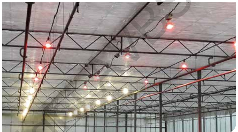
▲ Ophanging van de spaarlampen (achteraan) en de FocusLED-groeilampen (vooraan) in de serre
