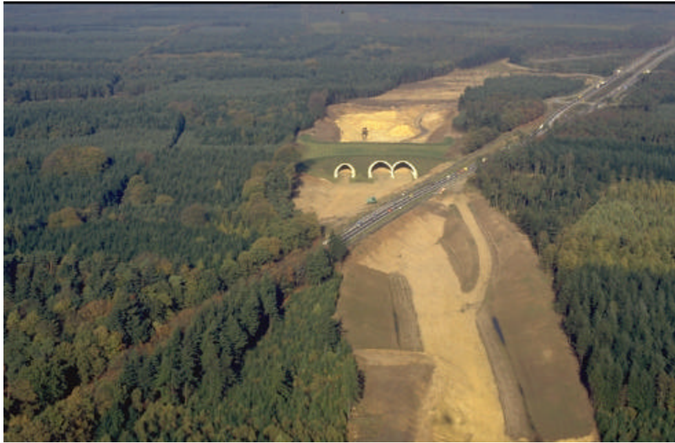
Fig. 6. Bij de aanleg van een nieuw tracé gelijktijdig en onder deskundige begeleiding ecoducten aanleggen is ecologisch en economisch het meest verantwoord.
