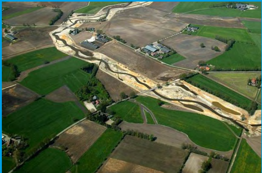
FIGUUR 2 Luchtfoto van de Doorbraak (bron: waterschap Vechtstromen, 2016)
