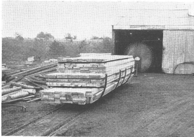
Afb. 88. Inrichting waarin het hout onder druk wordt geconserveerd. De wagon wordt in de ketel gereden.
