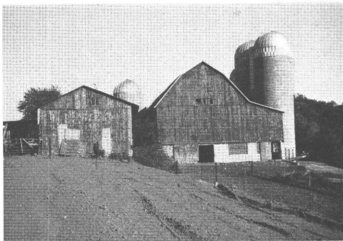
Afb. 7. Slecht onderhouden boerderij in Wisconsin. Rechts een drierijige grupstal voor 80 stuks melkvee met daarboven het hooi. Naast de stal torensilo's die met een bovenlosser worden gelost. De mest wordt rechts achter de stal door een automatisch mestafvoersysteem op de wagen gestort. De vorm van het dak wijst in de richting van een oorspronkelijk tweerijige stal.
