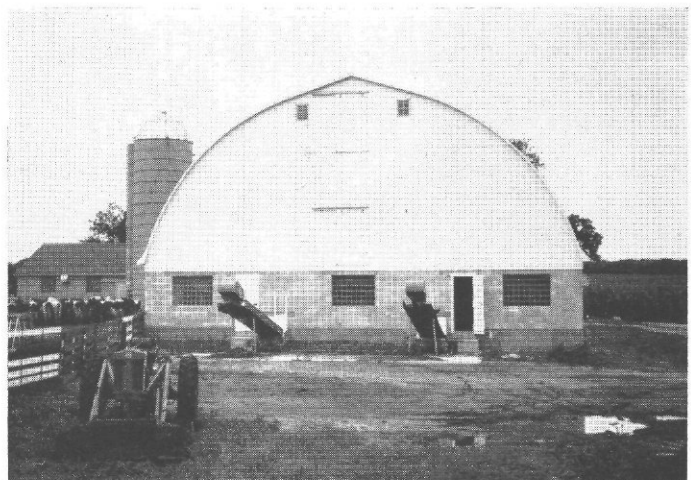
Afb. 41. De achterzijde van de grupstal van afb. 40 in werkelijkheid. Men ziet de twee opvoergoten met rondgaande ketting voor de mestafvoer. De op de foto staande smalle torensilo is niet meer voor het melkvee in gebruik.
