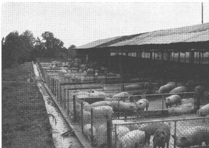
Afb. 55. Open loopstal voor varkens in een warmer klimaat in de V.S.A. Mest en gier worden links naar een mestvijver afgevoerd.
