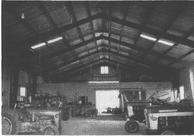
Afb. 95. Geprefabriceerde schuur, omwand en bedekt met gegalvaniseerd ijzeren golfplaten.
