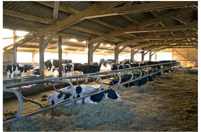
De voormalige hellingstal was te vlak, koeien liepen het stro niet goed naar beneden. Die is dus omgebouwd naar ligboxenstal.
