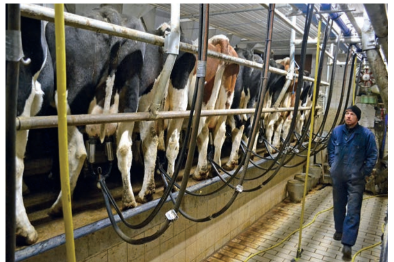
Aldert Lozeman melkt sinds eind 2015 in een 2 x 10-stands swing-over melkstal van Klesan, die hij grotendeels zelf heeft gebouwd.
