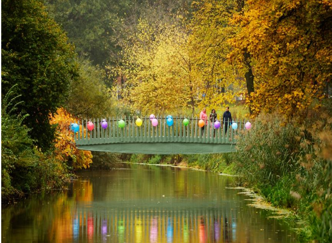
Afbeelding 59 Biocomposietbrug bij de opening in oktober 2016
