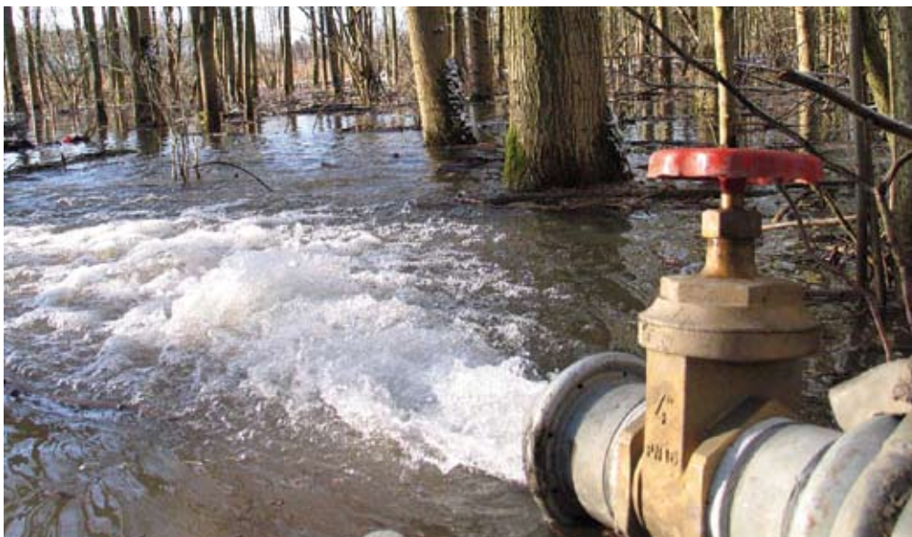
Figuur 6 Wateraanvoer in een compartiment met doseerkraan
