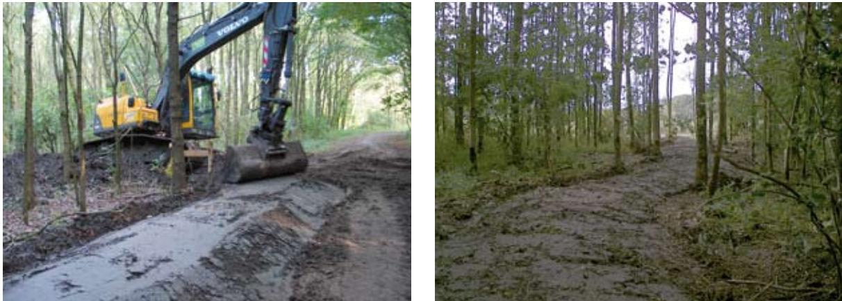
Figuur 2 Inrichting van de compartimenten door de aanleg van kleikades.
