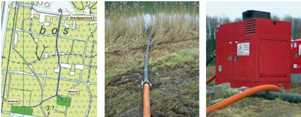
Figuur 5 Aanvoerleiding, innamepunt en pomp voor suppletie van de compartimenten.
